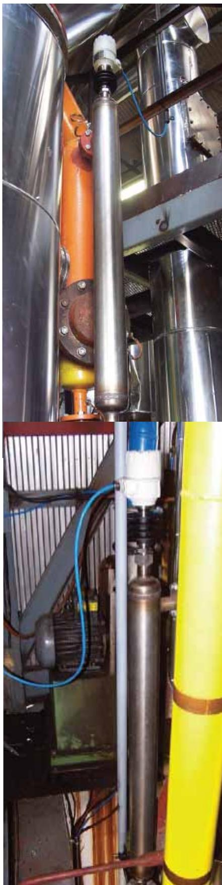
cambiador, es por eso que se debe instalar un tubo vertical comunicante para el transmisor.
